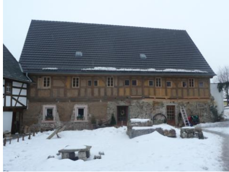
und das Wohnhaus im Februar 2009
