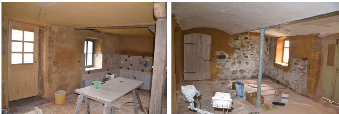
Abb.: Innenansicht Wohnhaus, links Küche, rechts Diele
